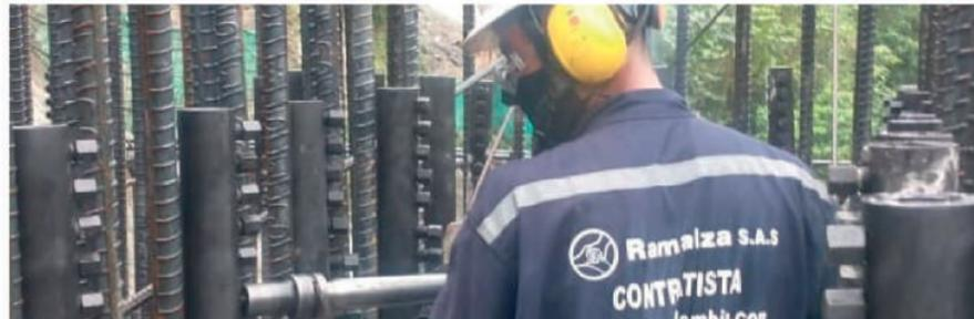
Los empalmes tipo 2 tornillo permite reparar las barras de refuerzo, logrando una continuidad completa en la zona de empalmado, se usa en cualquier tipo de elemento estructural.
